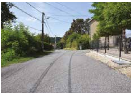
● Chemin du Lierre : réfection de voirie
