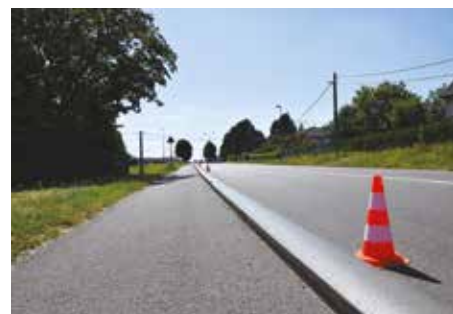
● Avenue Léon Jouhaux : terre-plein de sécurisation du cheminement piéton
