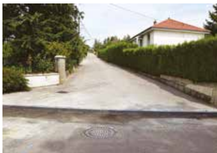
● Rue des Nouvelles : pose d'une grille suite aux inondations / réfection de voirie
