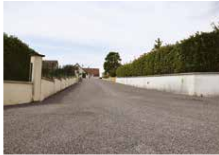
● Impasse du fer rouge : réfection de voirie
