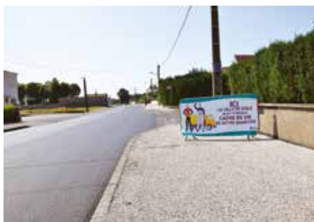
● Avenue Landon : travaux réfection voirie et trottoirs
