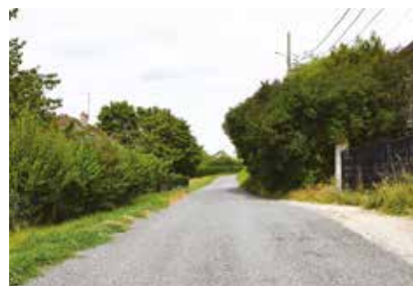
● Rue du renvers Plumont : réfection de voirie
