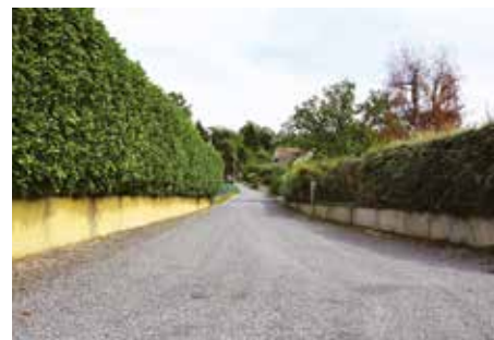
● Rue des Nouvelles : réfection de voirie
