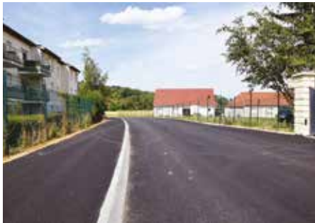
● Rue des Pacottes : réfection de la chaussée et des trottoirs
