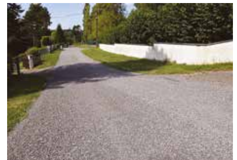
● Chemin du Lierre : réfection de voirie
