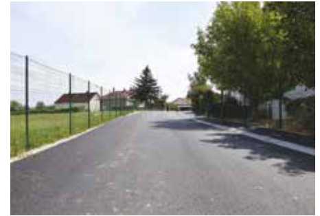
● Rue des Pacottes : réfection de la chaussée et des trottoirs
