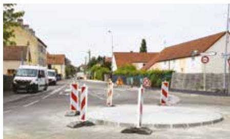
● Rue Claude Lombard : travaux de réfection voirie et trottoirs / création d'un terre-plein central
