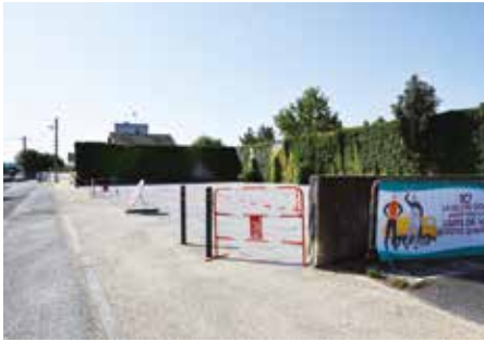
● Rue Blanche de Buxy : réfection de voirie
