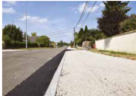
● Rue de Chaux : réfection des trottoirs
