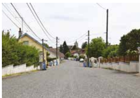
● Rue Louis de la Verne : réfection de voirie
