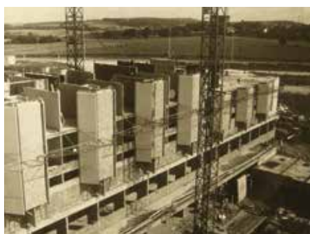
• Le CHLP en construction.
