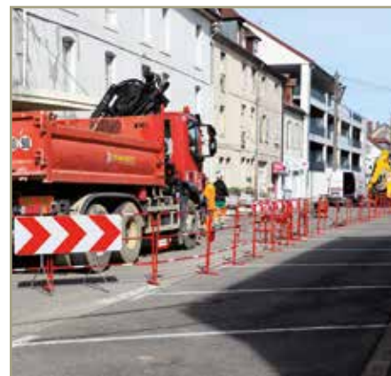
● Les travaux de l'avenue de Northwich ont débuté.
