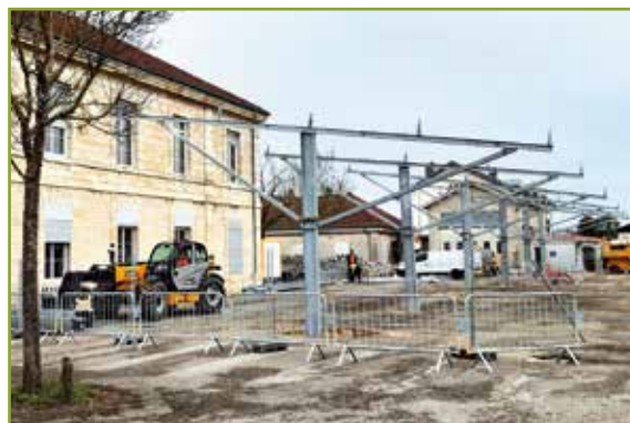
• Chantier de panneaux photovoltaïques sur ombrières au CTM.
