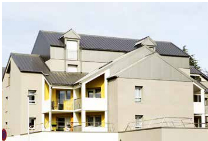
• Un bâtiment fonctionnel
