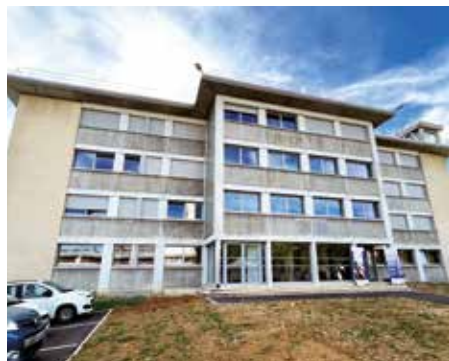
• Vue du bâtiment principal rénové.
