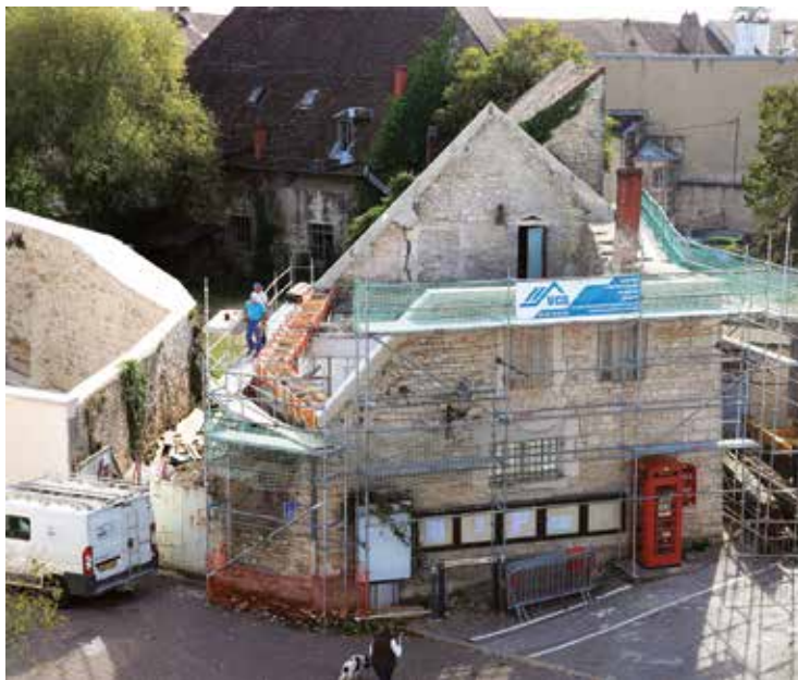
● L'ancienne serrurerie avant que la charpente ne soit posée.
